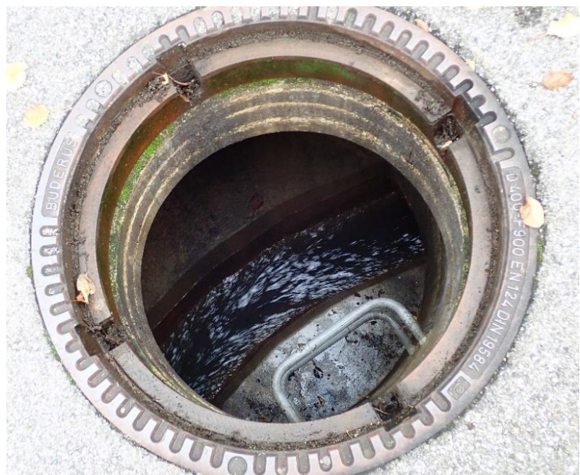
Einfache Sichtprüfung der Schächte - Bild: Gemeinde Palling
